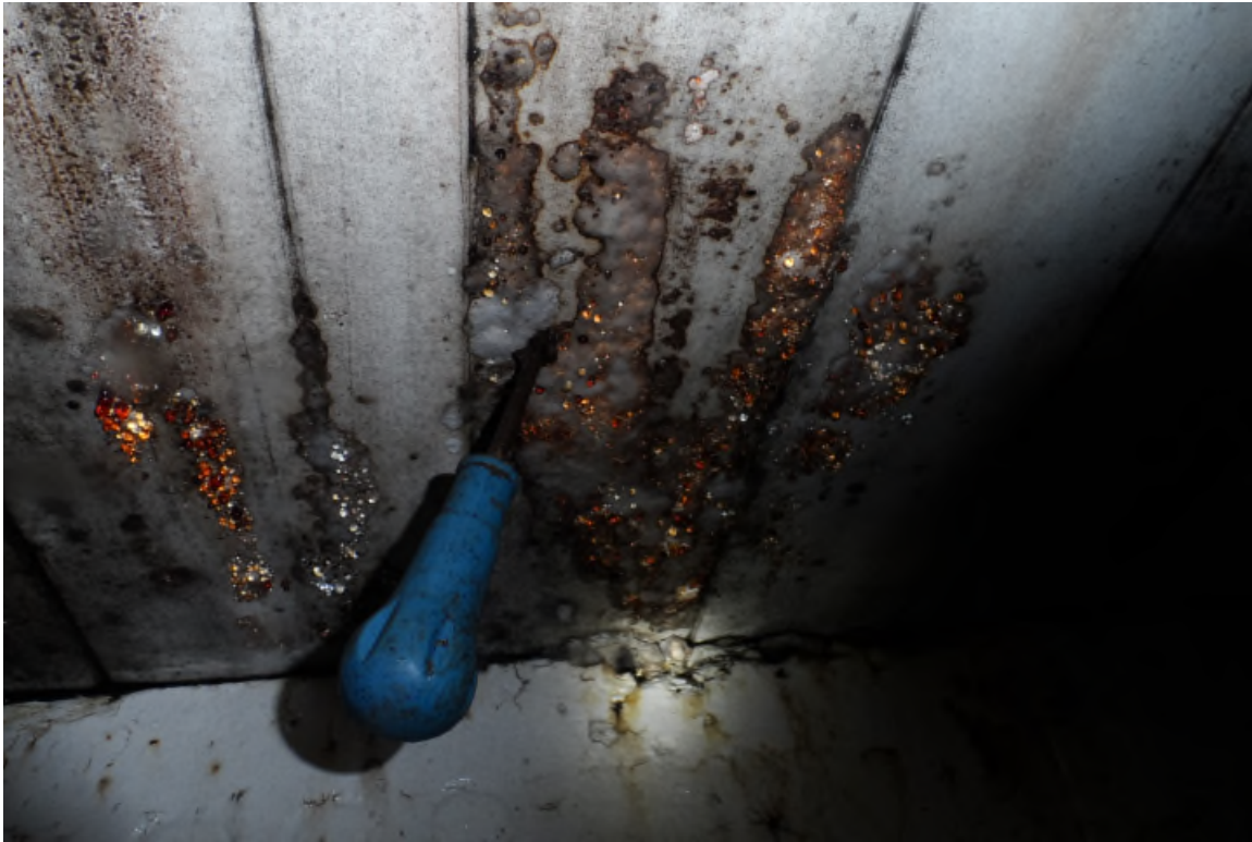
Fish Room 9.JPG
