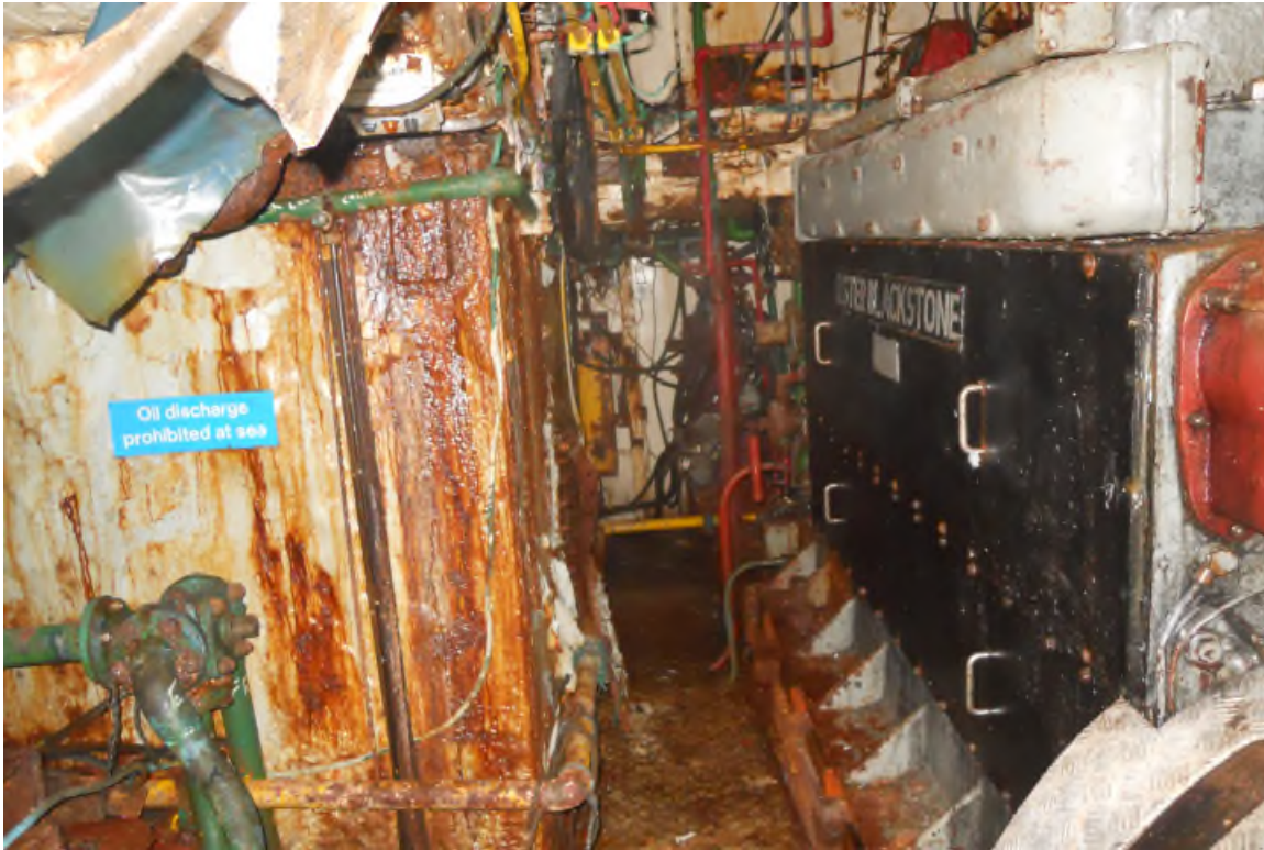
Engine Room 3.JPG
