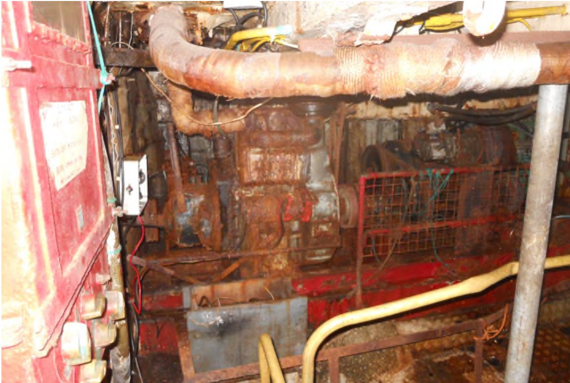
Engine Room 1.JPG
